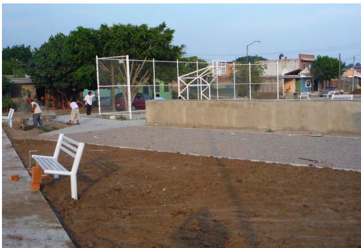
Preparación del terreno
