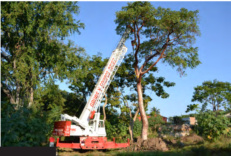
Retiro con grúa lowboy de 50 ton.
